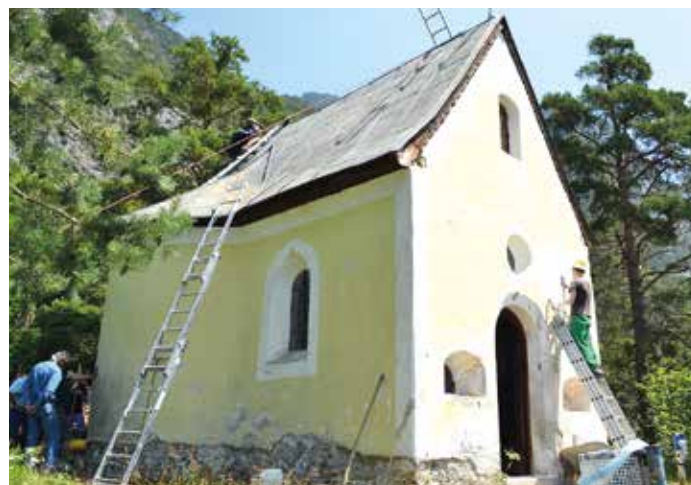
Zahlreiche Arbeiten wie Ausholzen, Mähen, Sockel Entfernen, Ein- und Ausrüsten, Dach entrostet, Grundieren, Verputzen, Streichen und Holzausbesserungsarbeiten waren notwendig.
