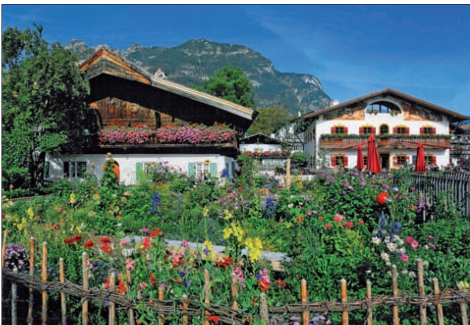
Das denkmalgeschützte „Polznkasparhaus“ in Garmisch.
